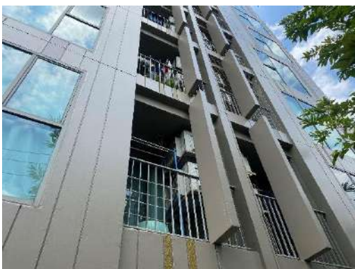
ภาพที่ 2.2-19 แนวระเบียงกันตกและช่องระบายอากาศ
